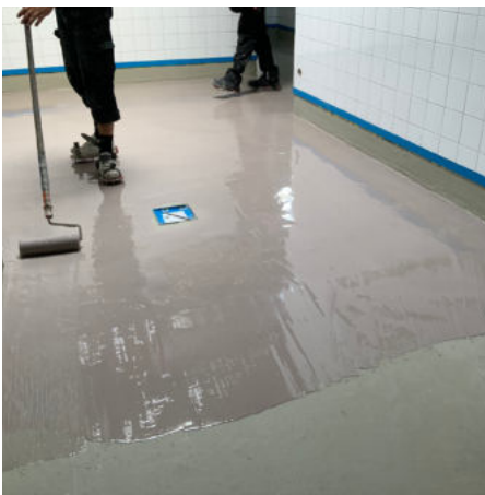
Flüssigfolienabdichtung mit TRIFLEX®-Systemkomponenten
