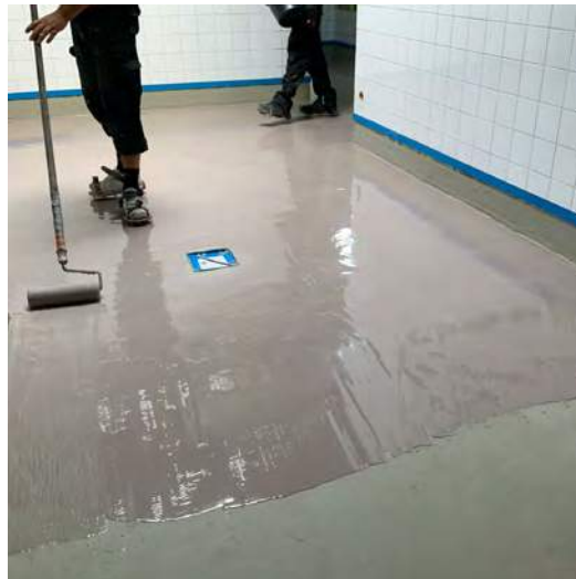
Flüssigfolienabdichtung mit TRIFLEX®-Systemkomponenten
