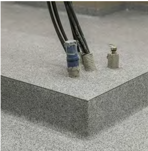
Gerätesockel mit Hohlkehle
